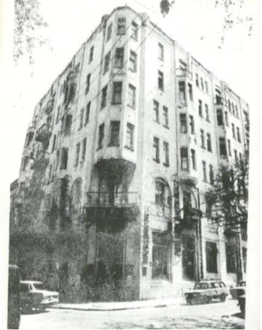
Göy-Göl meşmanxanasının binası.
